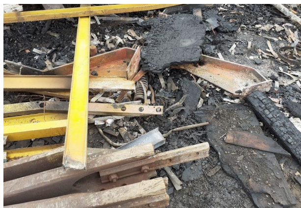
Déchets combustibles à proximité de la zone de découpage au chalumeau
